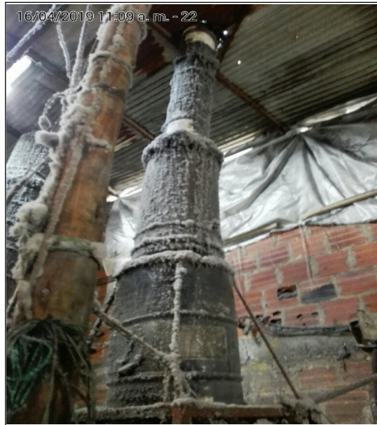
FOTOGRAFÍA No. 4: DUCTO AGLUTINADORA
